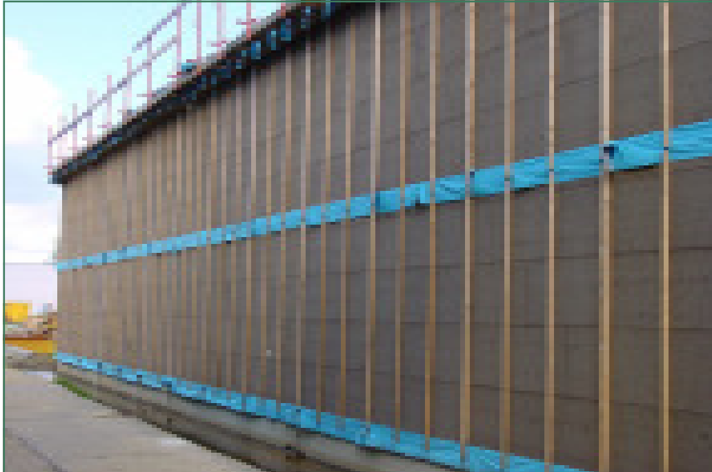
De halfzachte isolerende houtvezelplaat aan de buitenzijde van het skelet zorgt ervoor dat de constructie wind- en waterdicht is. Zoals hierboven al aangehaald, is deze plaat dampopen waardoor condensatie vermeden wordt.
