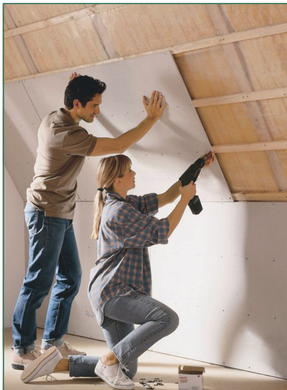
Gipsvezelplaten zijn sterker, meer brand- en geluidswerend dan gipskartonplaten.
