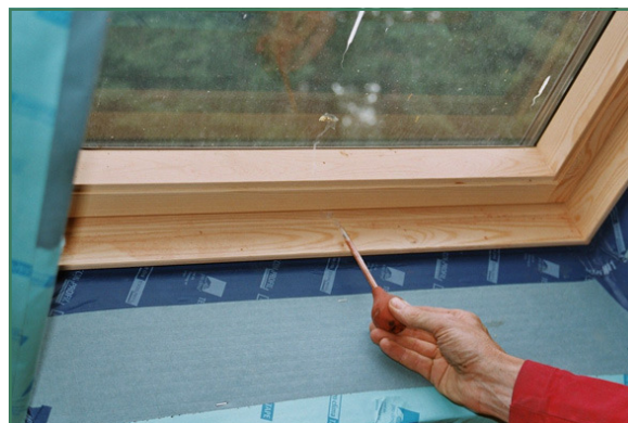
Een dakraam wordt getest op luchtdichtheid. De dakisolatie zit achter een papieren dampremmend membraan.
