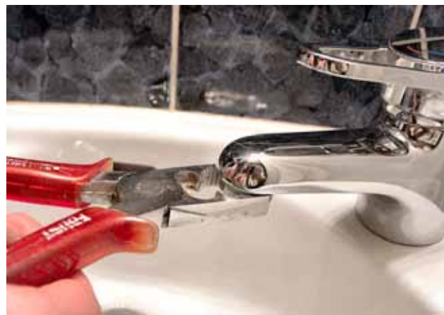
Een bruismondstuk kan je gemakkelijk zelf monteren. Bron: Keilmann
