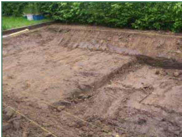
De uitgraving gebeurt met een talud van 45° Bron: B&B NV - Pure
