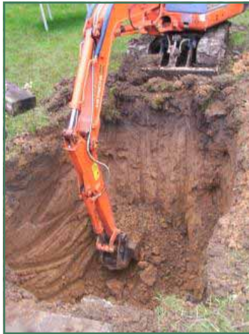
Het graafwerk kan met een kraantje of manueel uitgevoerd worden Bron: B&B NV - Pure
