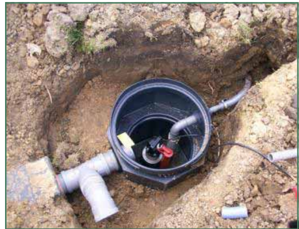
De plaatsing van de pomp Bron: B&B NV - Pure
