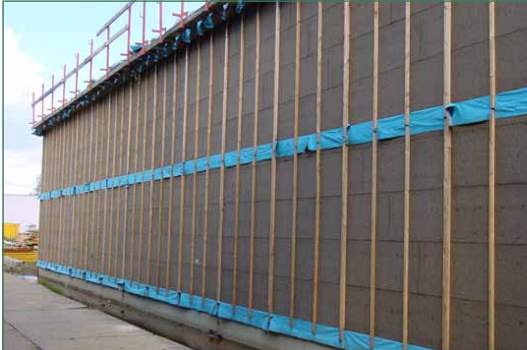
De halfzachte isolerende houtvezelplaat aan de buitenzijde van het skelet zorgt ervoor dat de constructie wind- en waterdicht is. Zoals hierboven al aangehaald, is deze plaat damopen waardoor condensatie vermeden wordt.
